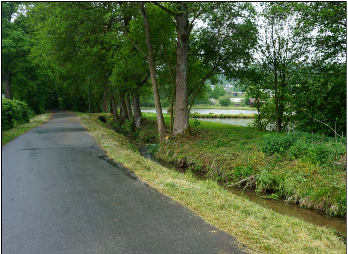
Bild 4: Erlichbach knapp unterhalb der geplanten Einleitstelle
